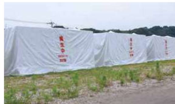
根固方塊ブロック
