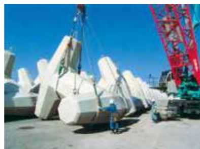
ドロス(80t)転置状況
