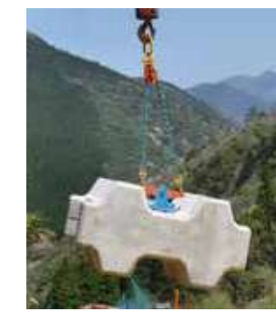
傾斜吊り状況
